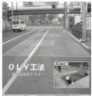
OLY工法は、まず最初に鋼製のL型部材「OLYプレート」を使用して掘工事の掘削を先行させる工法です。掘削後の作業はすべて掘工内で行うことができ、掘削掘り戻していた掘削・埋戻し・仮覆削といった作業を削減できます。それにより使用材料・運搬車両台数も削減でき、適宜効果ファスの削減も可能になり、地球温暖化防止の取り組みに大きく貢献しています。
